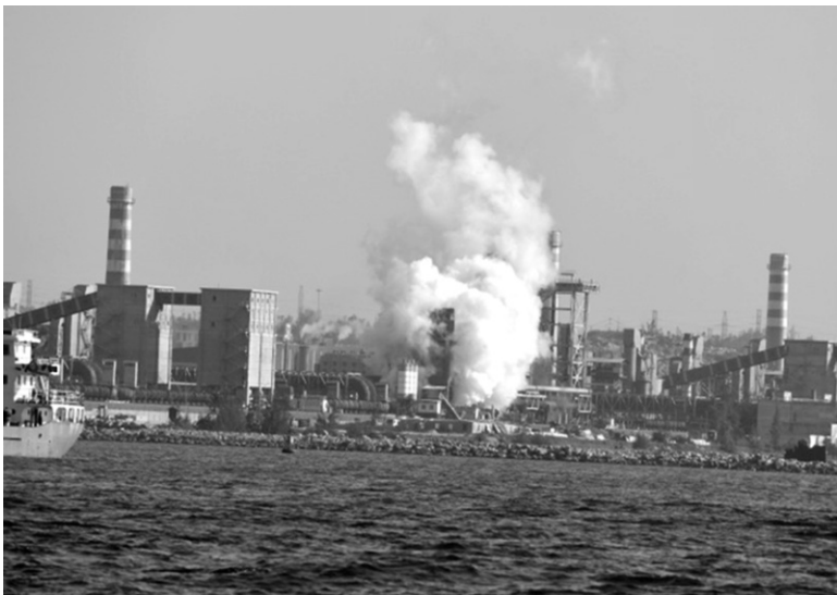
● Một góc nhà máy thép của Hòa Phát tại Dung Quất.
