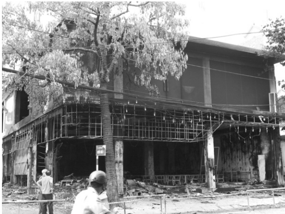
● Hiện trường vụ cháy.
