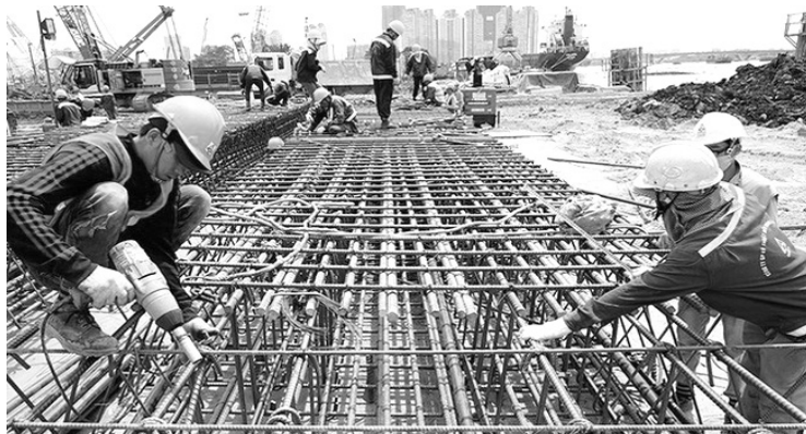
● Công nhân làm việc trên công trình.
