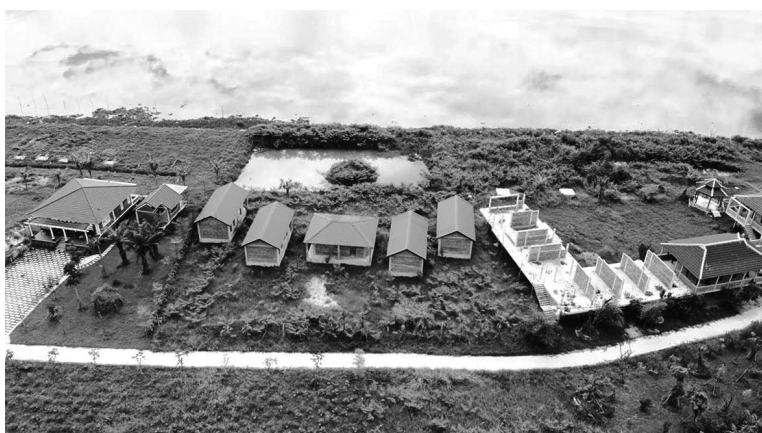
● Nhiều công trình xây dựng không phép tại dự án Sản xuất nông nghiệp và dịch vụ sinh thái Go Green Farm.
