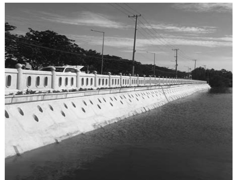
● Đoạn kè sông Dinh bằng cấu kiện lắp ghép bảo vệ bờ sông, hồ và đê biển.
