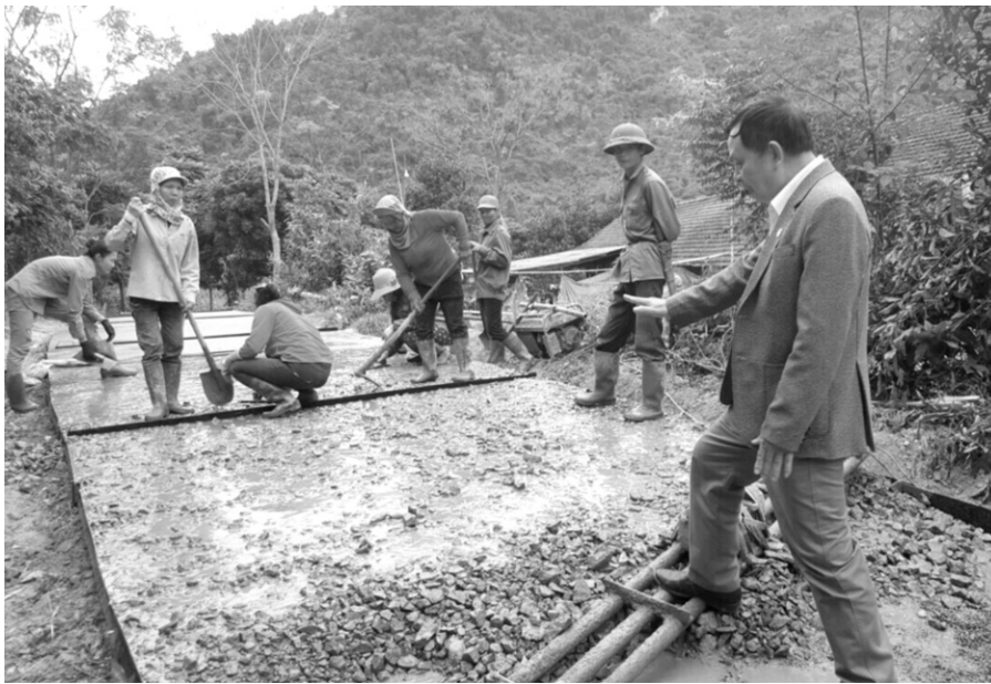
● Giám sát thi công đường nông thôn.
