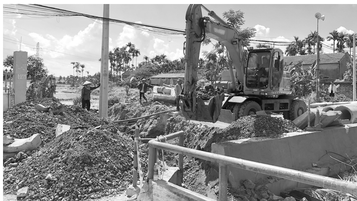
● Các tuyến đường nông thôn mới kiểu mẫu giai đoạn hai đang dần hoàn thiện ở Gia Đức.
