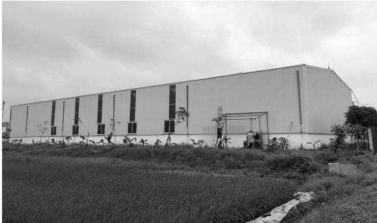
● Nhà xưởng được xây dựng từ 2020 nhưng đến nay chưa hoàn thiện thủ tục pháp lý.
