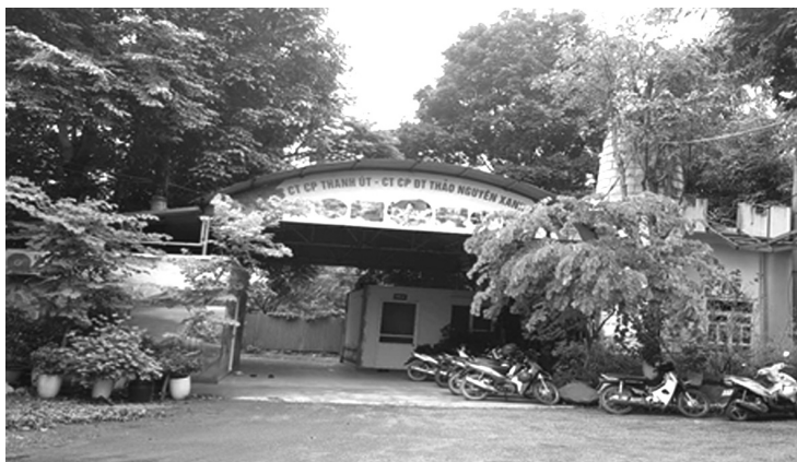
● Nhiều sai phạm tại dự án của Cty Thanh Út nhiều năm chưa được xử lý dứt điểm.
