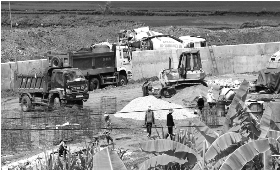
● Dự án đang trong giai đoạn thi công
