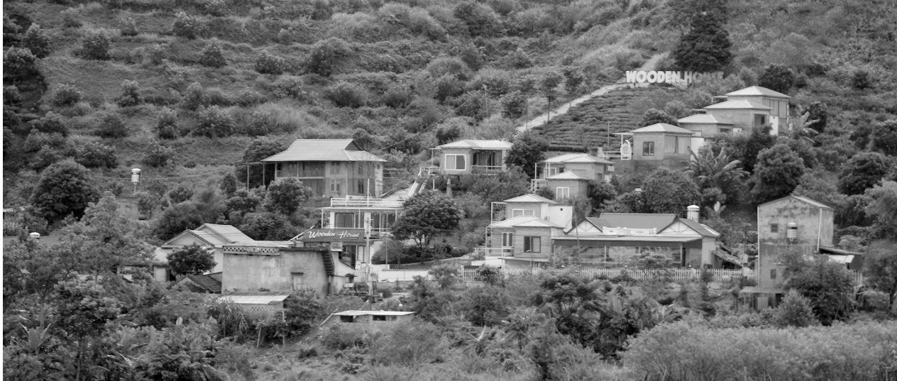
● Wooden House Mộc Châu (bản Chiềng Đì) xây năm 2020 không có giấy phép xây dựng.
