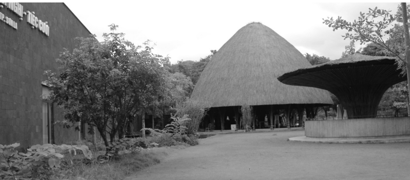
Nhiều hạng mục công trình trong dự án không có giấy phép xây dựng.
