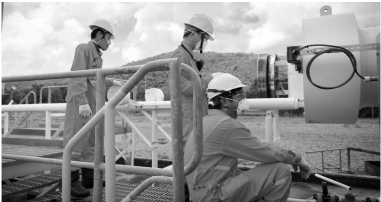
● Công nhân làm việc tại Nhà máy xử lý khí Nam Côn Sơn.
