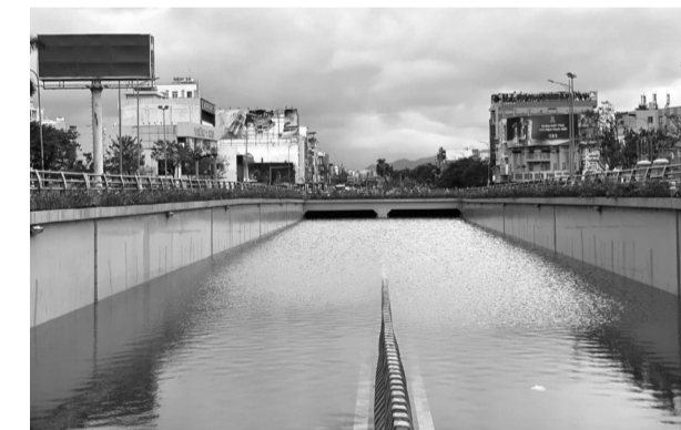
● Một hầm chui ngập nước sau đợt mưa lịch sử tại TP Đà Nẵng. (Ảnh trong bài: Lưu Hương)
