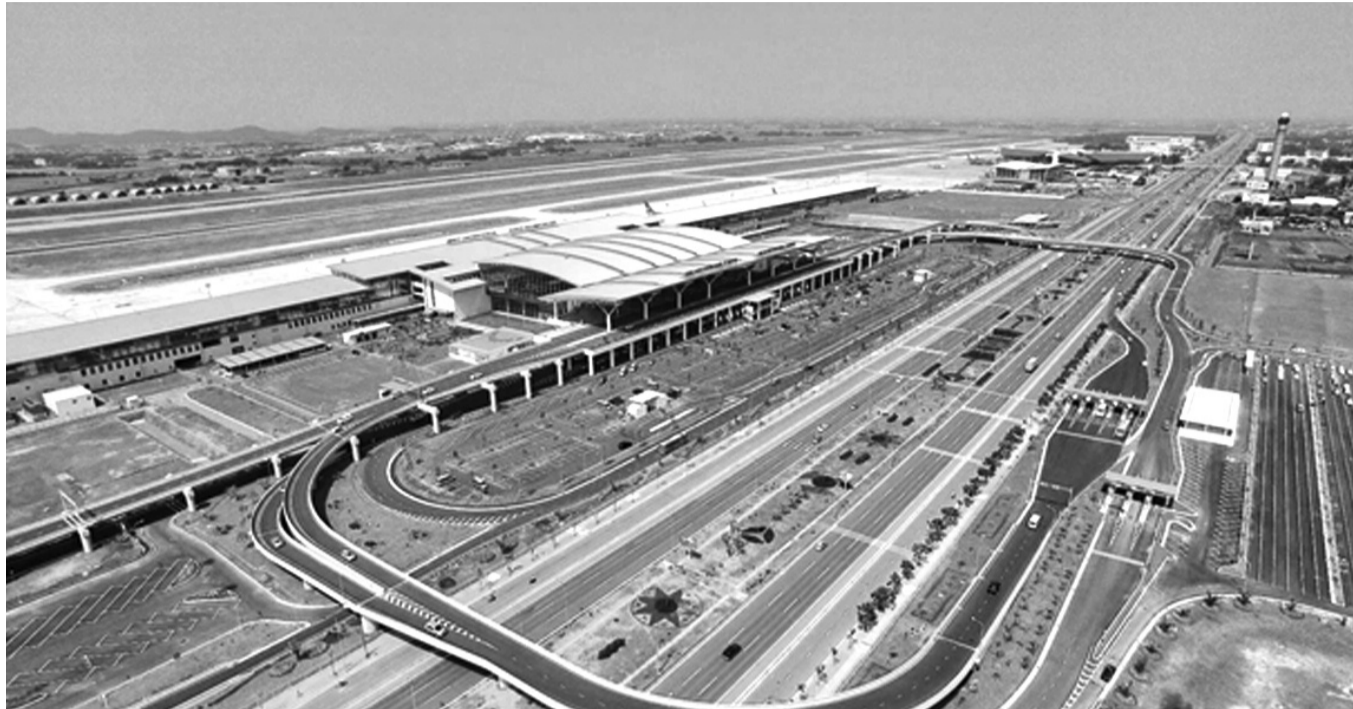
● Nhà ga T2 Nội Bài hiện có công suất 10 triệu khách/năm. (Ảnh: ACV)
