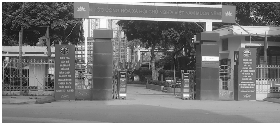
● Trụ sở UBND huyện Thường Tín, thành phố Hà Nội.
