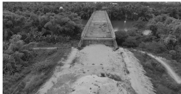
● Một cây cầu xây xong nhưng chưa hoàn thành đường dẫn.
