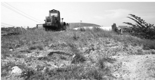
● Cảnh hoang vắng tại công trường xây dựng một cây cầu.
