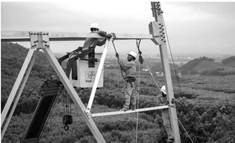
●Khẩn trương hoàn thành lưới điện trong tháng 6. (Ảnh: PV)
