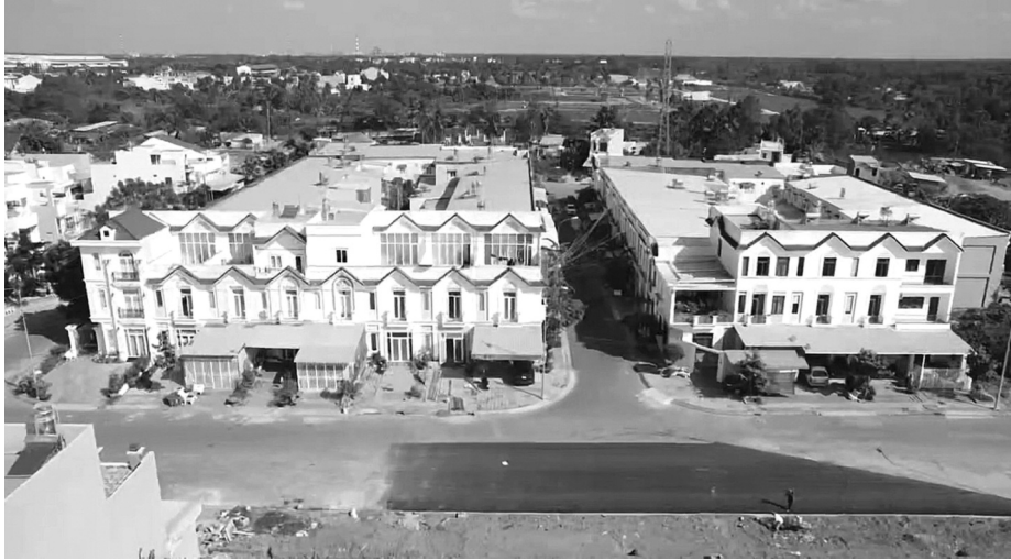
● Một góc dự án do Công ty Phúc Thanh Vinh thực hiện. (Ảnh: Trần Tiến)
