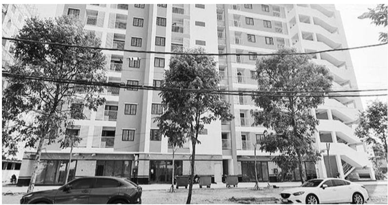
● Là một trong những dự án NOXH tại TP Cần Thơ, hiện dự án chung cư Hồng Loan 5C đã bàn giao được 332/1.036 căn. (Ảnh: Long Vĩnh)
