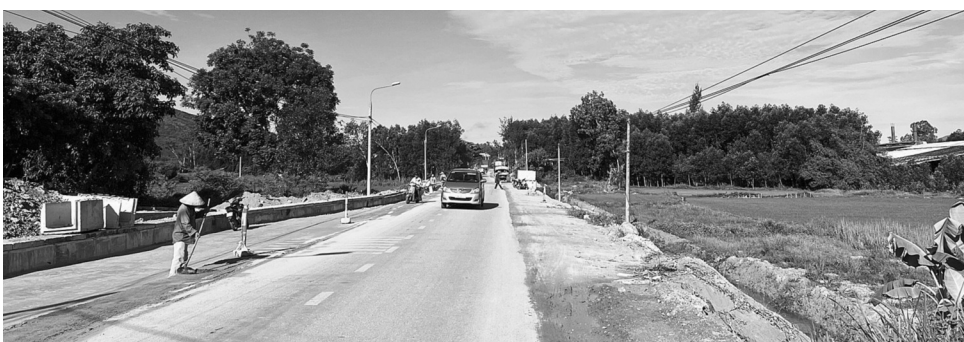
● Dự án cải tạo, nâng cấp QL14E qua địa bàn tỉnh Quảng Nam vẫn đang gặp khó ở công tác giải phóng mặt bằng. (Ảnh: PV)
