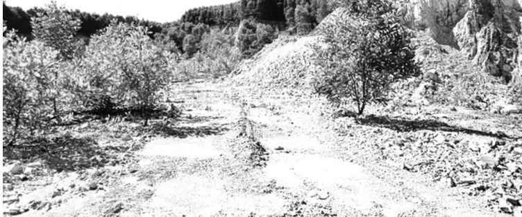
● Một mỏ đất san lấp vật liệu dù thời hạn khai thác đã hết nhưng DN vẫn chưa thực hiện công tác đóng cửa mỏ, phục hồi môi trường. (Ảnh: Thùy Nhung)
