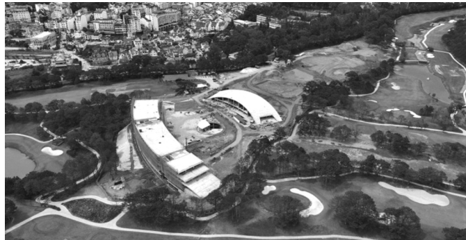
● Toàn cảnh dự án Tòa nhà CLB Golf thuộc sân Golf Đồi Cù Đà Lạt.
