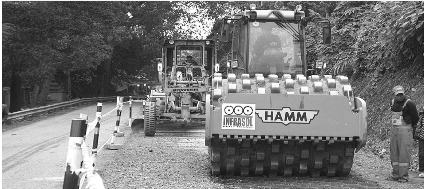
● Sửa chữa bảo trì tại QL32. (Ảnh: PV)
