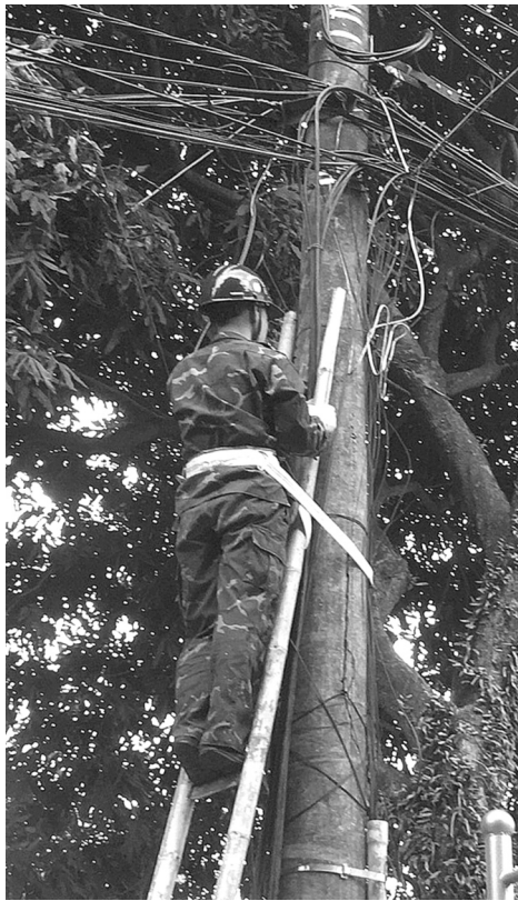
● Bộ đội kiểm tra sự cố, sửa chữa đường dây TTLL.
