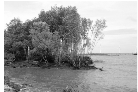
● Tuyến đê biển Đông, đoạn giáp ranh giữa tỉnh Bạc Liêu và Sóc Trăng xảy ra sạt lở nghiêm trọng. (Ảnh: Trọng Nghĩa)
