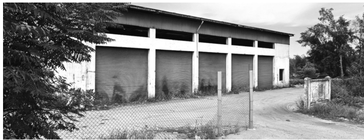
● Công trình không hoạt động nhiều năm nay, hiện không còn phù hợp quy hoạch quản lý chất thải rắn của Thừa Thiên Huế. (Ảnh: Thùy Nhung)
