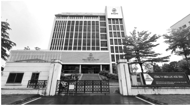
● Trụ sở Công ty Điện lực Hòa Bình. (Ảnh trong bài: Gia Hải)
