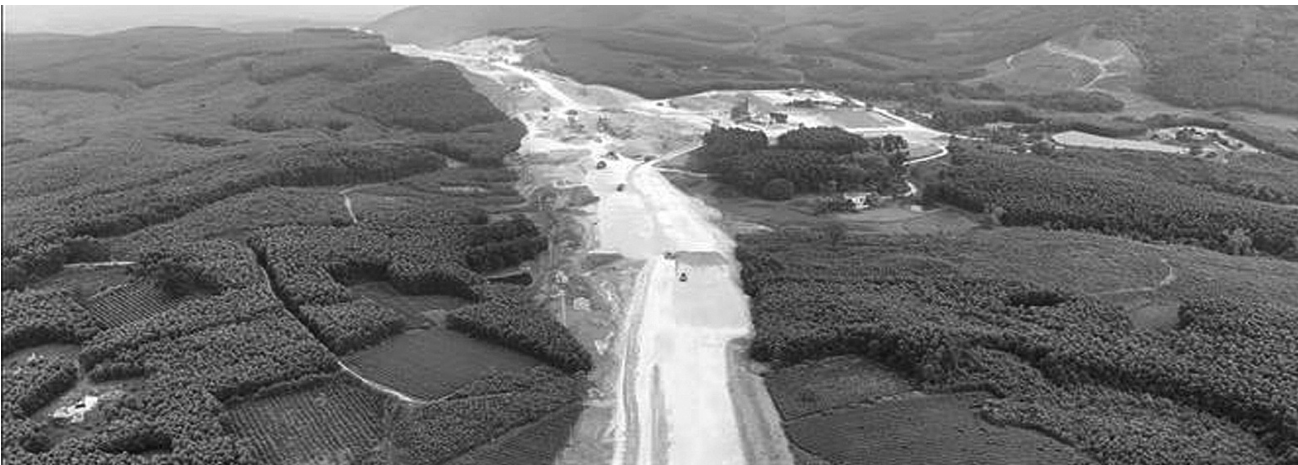
● Một đoạn thuộc dự án thành phần cao tốc Bắc - Nam đoạn Hàm Nghi - Vũng Áng đi qua huyện Kỳ Anh, tỉnh Hà Tĩnh. (Ảnh: TTXVN)
