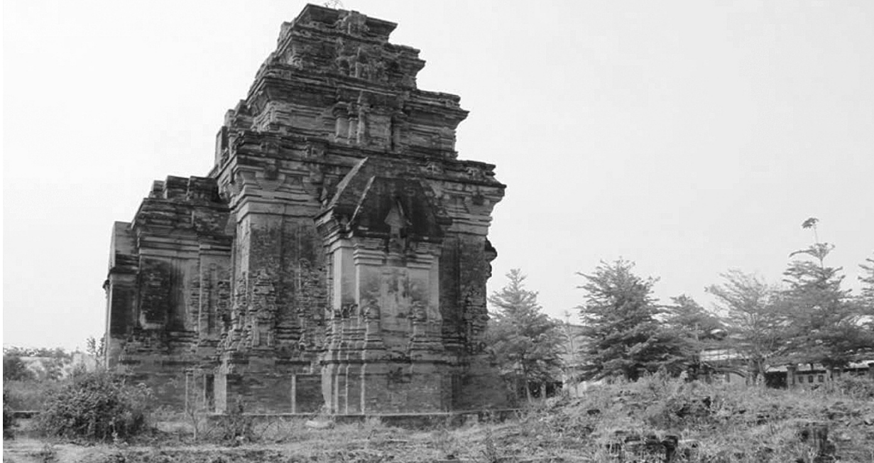
Tháp Hòa Lai (thuộc xã Bắc Phong, huyện Thuận Bắc, tỉnh Ninh Thuận) được Thủ tướng Chính phủ xếp hạng Di tích cấp Quốc gia đặc biệt, tuy nhiên, Khu di tích này đang bị xuống cấp.
