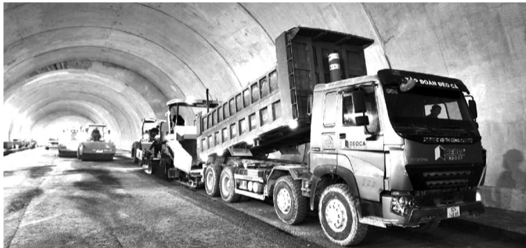
● Trên công trường dự án cao tốc Bắc - Nam đoạn Quảng Ngãi - Hoài Nhơn. (Ảnh: Vũ Văn Anh)
