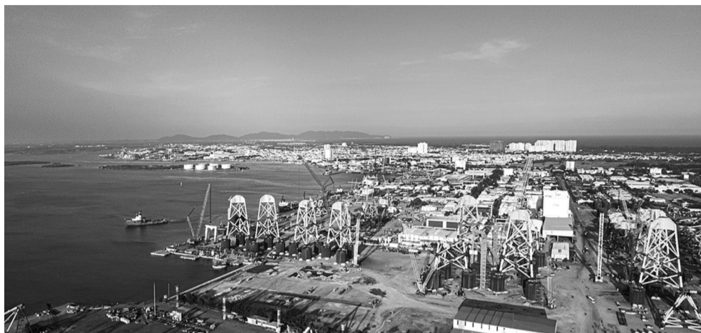
● Công trường thi công chân đế điện gió ngoài khơi tại cảng PTSC. (Nguồn: PVN)
