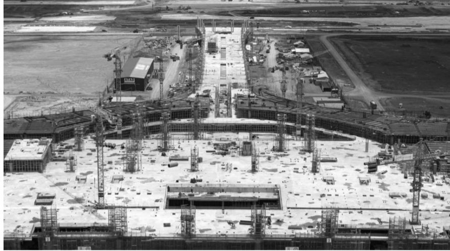
● Sân bay Long Thành đã hoàn thành các hạng mục thi công giai đoạn 1. (Nguồn: PV)
