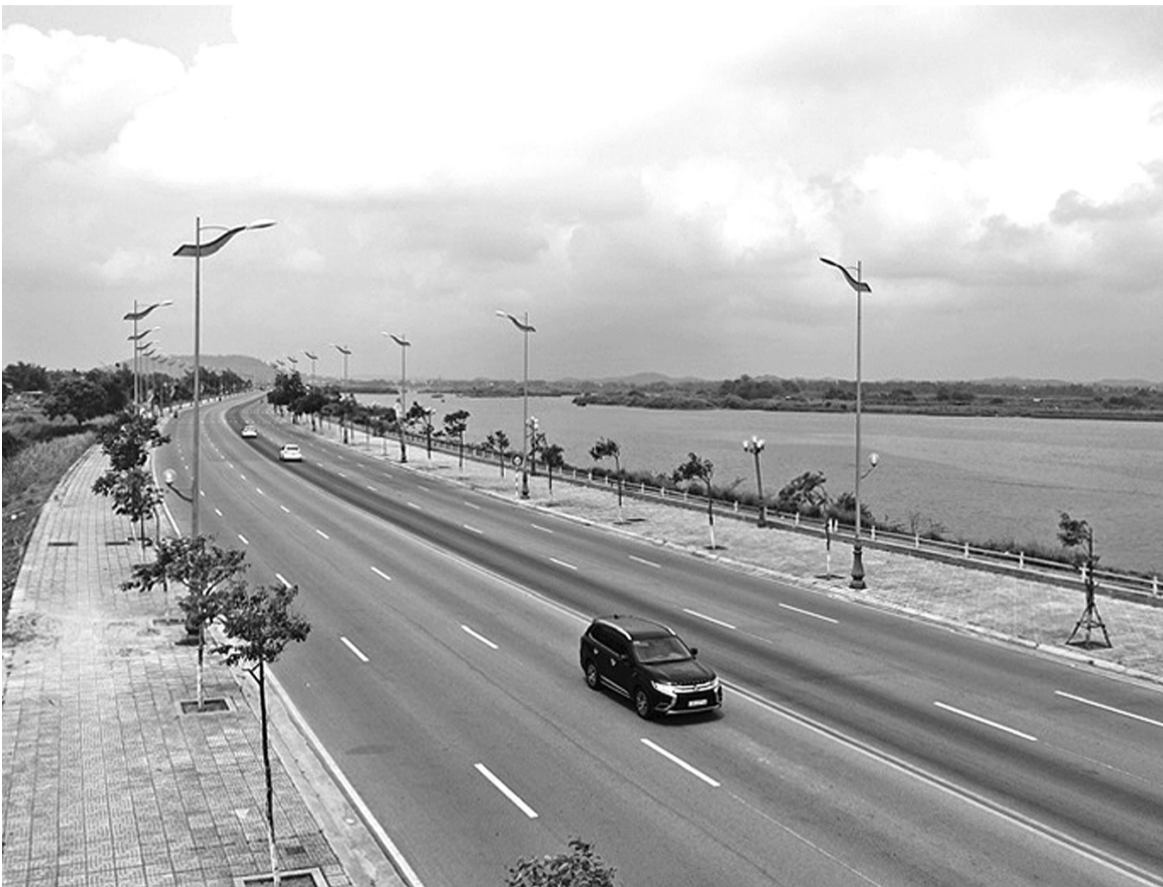
● Dự án đường bờ Nam sông Trà Khúc (Quảng Ngãi) với vốn đầu tư gần 1.000 tỷ đồng - một trong những dự án mà Tập đoàn Phúc Sơn trúng thầu. (Ảnh: Viên Nguyễn)
