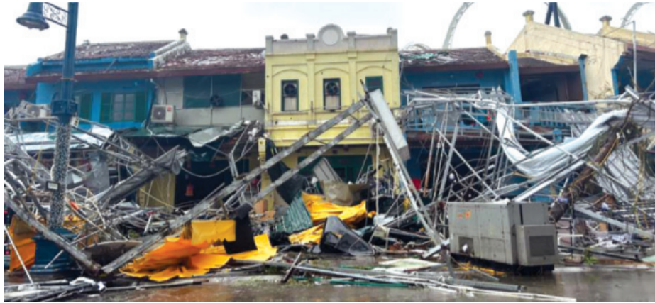
● Nhiều nhà cửa, công trình bị sập đổ tại Quảng Ninh.
