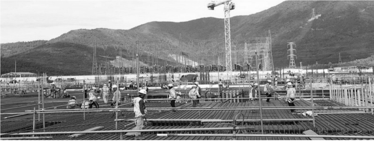
● Trên công trường xây dựng Trung tâm Điện lực Quảng Trạch (Quảng Bình).
