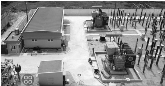
● Tân Uyên đã bàn giao khu đất cho đơn vị thi công xây dựng trạm biến áp 110kV Khánh Vân và đường dây đầu nối.
