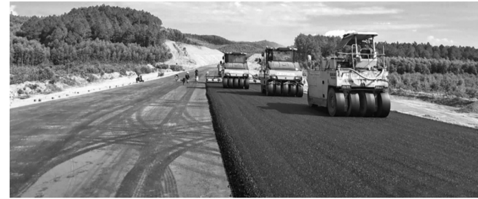
● Thi công cao tốc Bắc - Nam đoạn Bùng - Vạn Ninh. (Ảnh: Tạ Hải)
