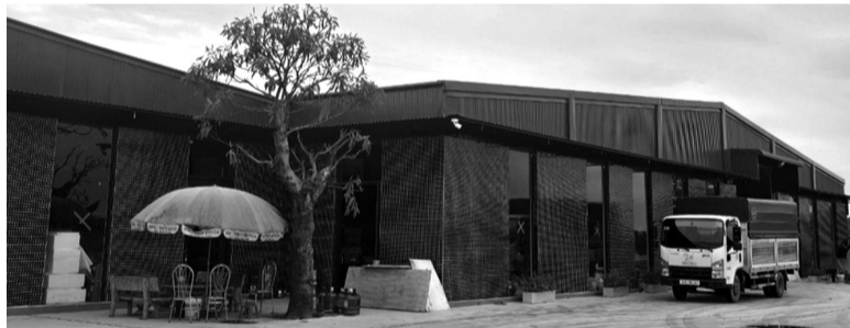
● Cận cảnh một trong những công trình vi phạm.
