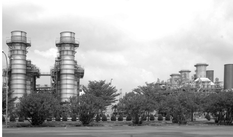
● Nhà máy điện khí Phú Mỹ 4 và Phú Mỹ 1 là những dự án điện khí đầu tiên ở Việt Nam. (Ảnh: EVN)
