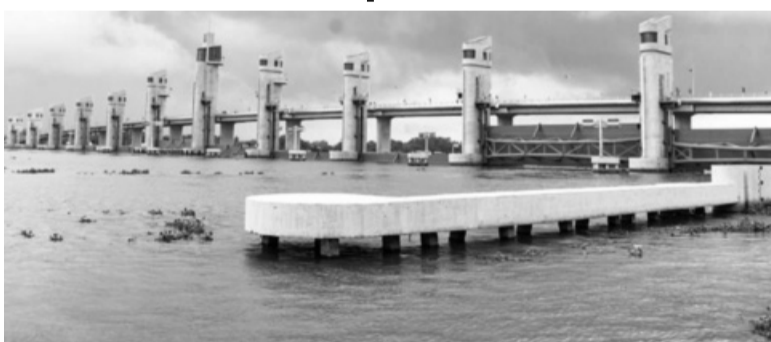
● Công trình thủy lợi cống Cái Lớn - Cái Bé. (Ảnh: CTV)
