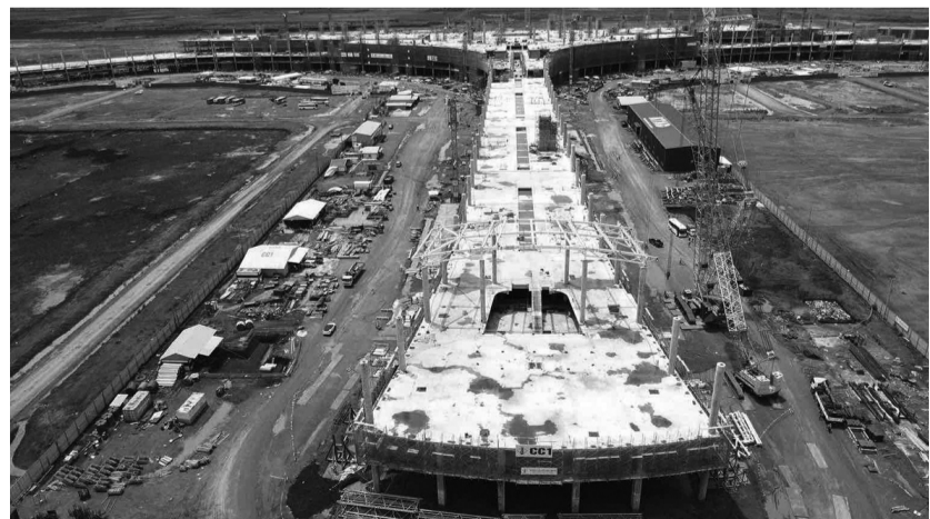
● Dự án sân bay Long Thành đang được xây dựng. (Ảnh: Thiên Phúc)
