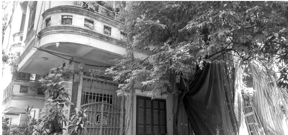
● Căn nhà ông Cảnh liền kề công trình đang được phá dỡ. (Ảnh: Nguyễn Tuấn)
