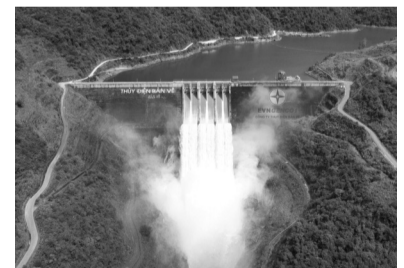
● Nhà máy Thủy điện Bản Vẽ. (Ảnh: Tâm Bảy)
