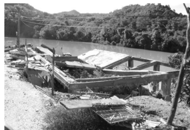
● Những ngôi nhà hạ lưu Thủy điện Bản Vẽ bị đổ sập hồi năm 2018. (Ảnh: Ngô Toàn)
