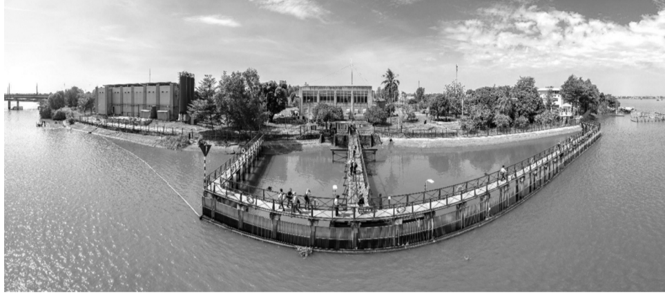
● Trạm bơm An Hòa.
