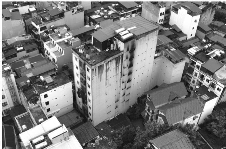
● Căn nhà bị tự ý thay đổi thiết kế công trình, xây dựng thành 9 tầng và 1 tum, vượt 3 tầng và 12 phòng. (Ảnh: Hồng Mây)
