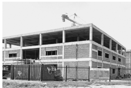
Một công trình xây dựng không phép của Cty Anctek Việt Nam.
