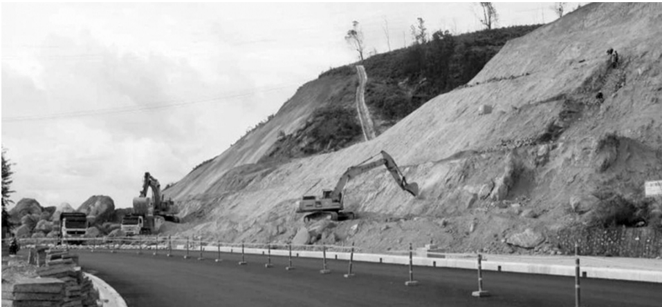
● Bí thư Tỉnh ủy Quảng Ninh yêu cầu tất cả các dự án đầu tư công đang triển khai phải đẩy nhanh tiến độ thi công. (Ảnh minh họa)
