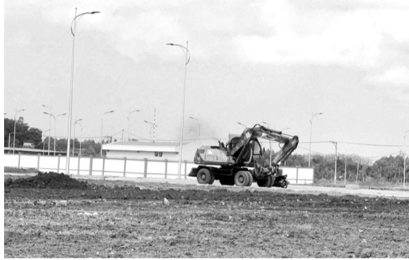
● Hiện nay, trên địa bàn Đồng Nai đang triển khai thi công 12 công trình, dự án trọng điểm dẫn đến thiếu hụt VLXD cho các dự án.
