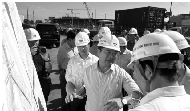
● Chủ tịch UBND TP HCM Nguyễn Văn Đước chỉ đạo tại công trường dự án nút giao An Phú.
