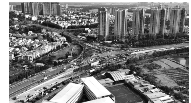
● Dự án nút giao An Phú là công trình trọng điểm ở cửa ngõ phía đông TP HCM. (Ảnh trong bài: Huỳnh Phúc)
