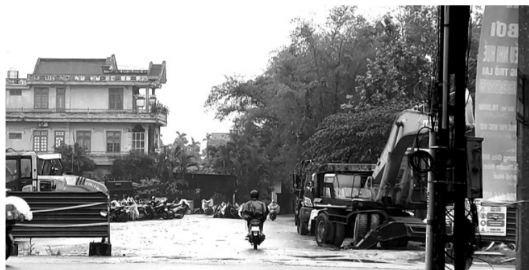
● Công tác GPMB để thi công đường Lâm Hoàng nối dài còn chậm, buộc công trình ngừng thi công. (Ảnh: Thủy Nhung)
