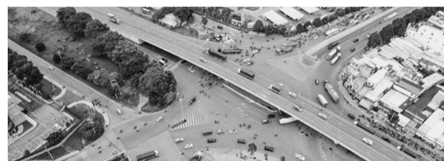
● Dự án tuyến đường trên cao dọc QL51 vừa giúp giao thông thông suốt, còn đóng vai trò quan trọng trong việc kết nối vùng.
