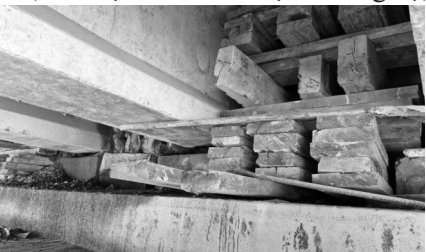
● Cơ quan quản lý dùng ván gỗ kê dưới móng cầu Rác tránh hư hỏng lan rộng. (Ảnh: Hữu Anh)
