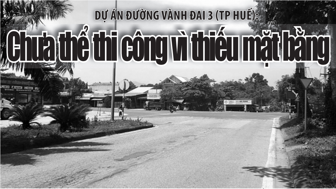
● Giao lộ Võ Văn Kiệt và Minh Mạng là điểm cuối của dự án đường vành đai 3 TP Huế. (Ảnh: Thùy Nhung)
