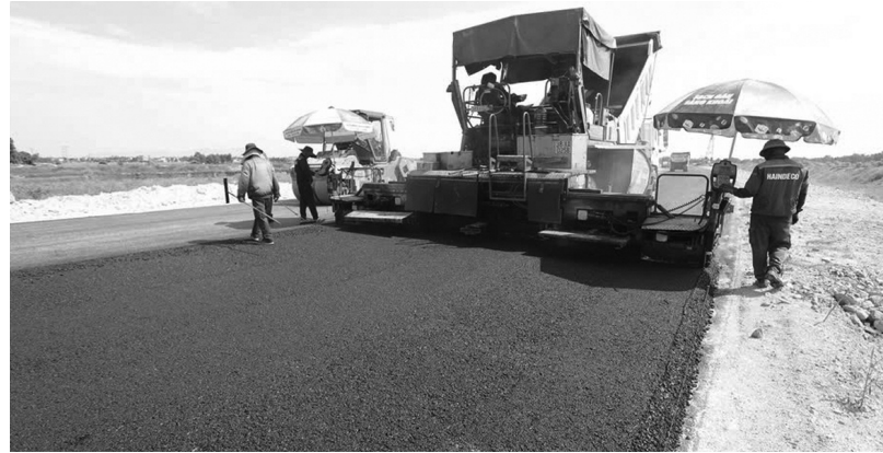
● Ngành xây dựng đang triển khai đồng loạt nhiều dự án xây dựng kết cấu hạ tầng giao thông trên phạm vi toàn quốc. (Ảnh: Báo Xây dựng)
