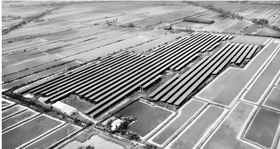
● Công trình điện mặt trời ở huyện Phước Long, tỉnh Bạc Liêu. (Ảnh: KT)
